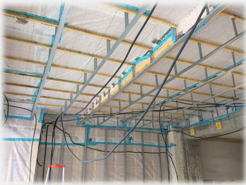
Ossatures BA 13 posées à 60 axe à axe
