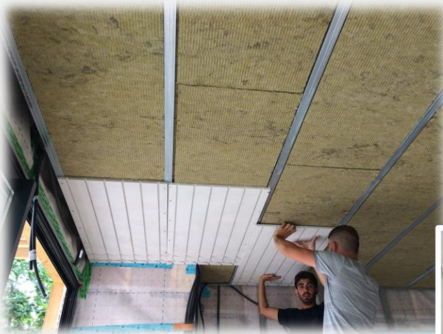
Plaques Raytop vissées sous l'ossature
