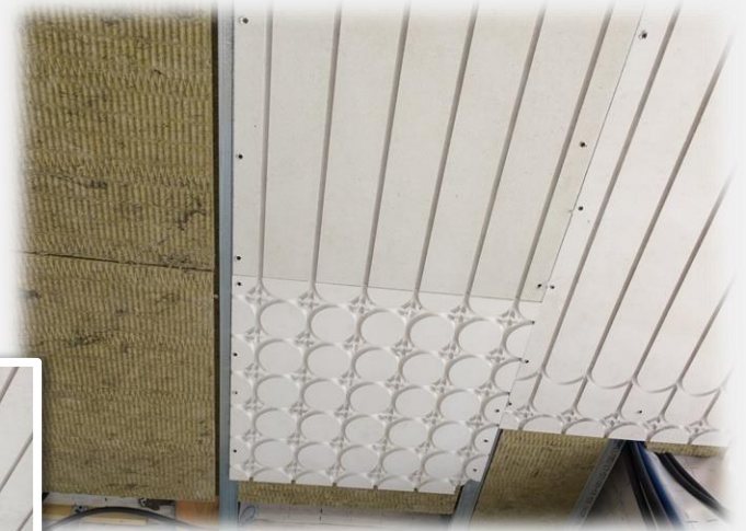
Plaques Raytop parallèles à l'ossature
